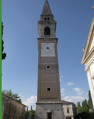
CAMPANILE DELLA CHIESA DI SANTA MARIA IN COLLE
