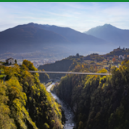
VEDUTA DELLA PASSERELLA SULLE CASSANDRE DEL MALLERO
