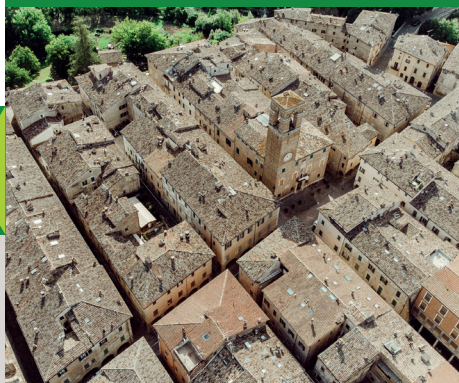
CENTRO STORICO URBANIA VISTA DAL DRONE
