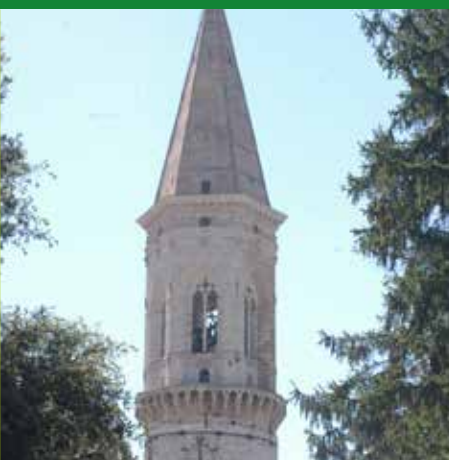
CAMPANILE DELL'ABBAZIA DI SAN PIETRO
