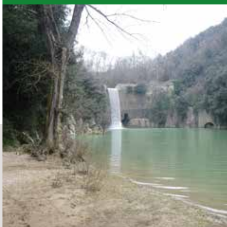
DIGA MEDIEVALE PRESSO IL RIO GRANDE
