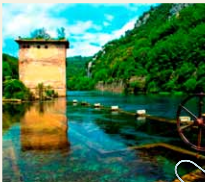
GOLE DEL NERA - PARTICOLARE DELL'ANTICA CENTRALE ELETTRICA DI STIFONE
